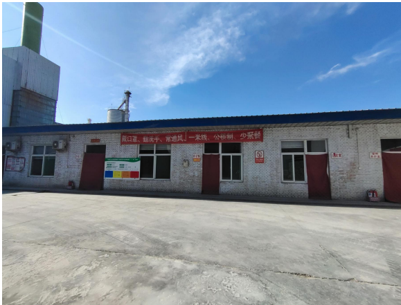
施工生活区及硬化
